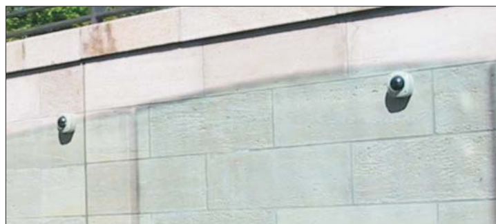
Lichtschrankenempfänger 30° in Dom-Kameragehäuse
