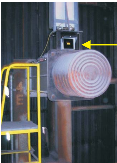
Chargierkran mit INET 100 Übertragungsbereich 1,5 m ... 350 m (Kranbahnlänge)
