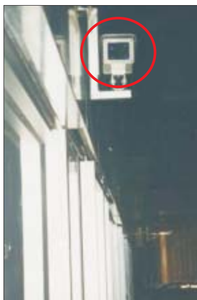
Abb. 4 • Endstation Kuala Lumpur Airport - ERL Türsteuersignale werden vom Zug zum Bahnsteig übertragen
