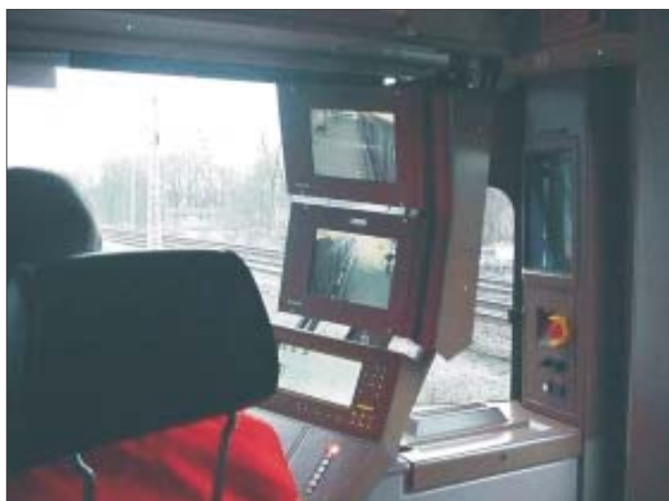
Abb. 2 • S-Bahn Berlin GmbH Linie S1 Führerstand mit IR-Receiver und zwei TFT Monitoren (Receiver oberhalb des Fahrers)
