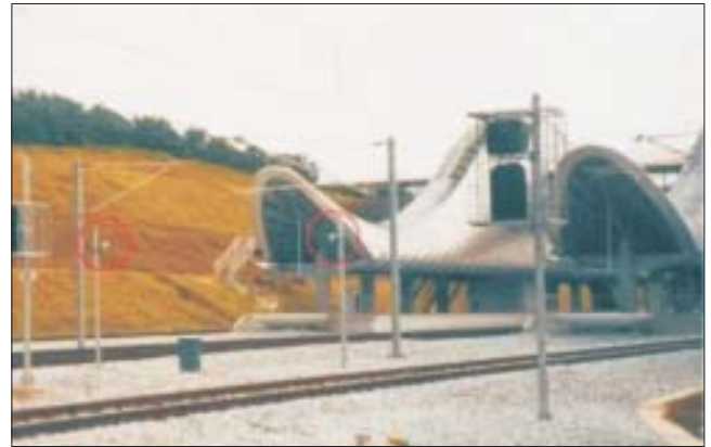
Abb. 6 • Express Rail Link KLIA in Kuala Lumpur IR Transmitter neben den Gleisen
