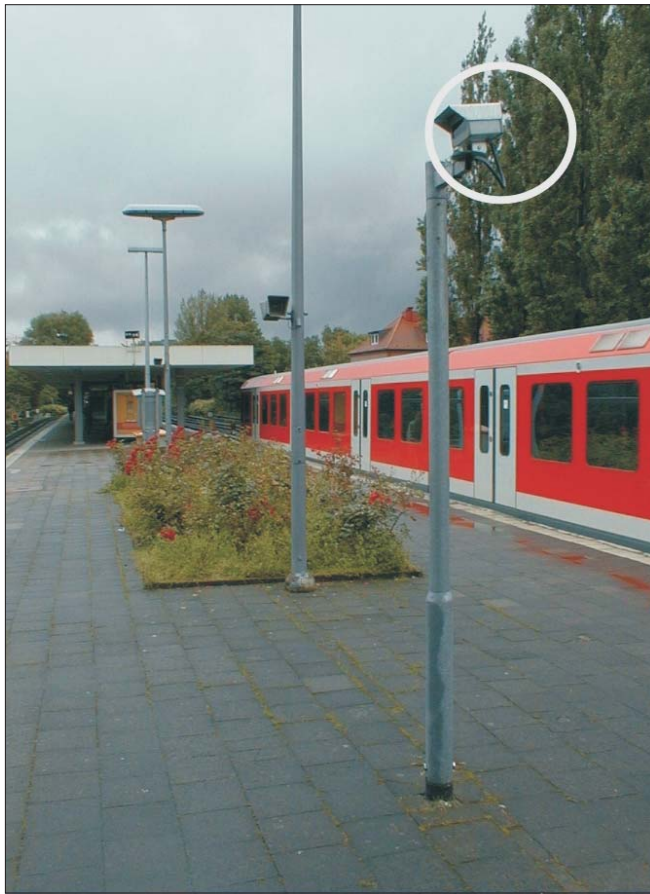
Abb. 1 • Infrarot - Präsenzdetektor FLG 10-20
