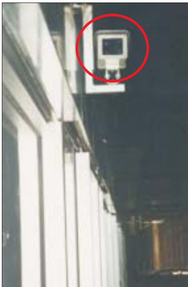
Fig. 4 • Gare terminus Kouala Loumpour Airport – ERL télécommande des portes de quai depuis le train.
