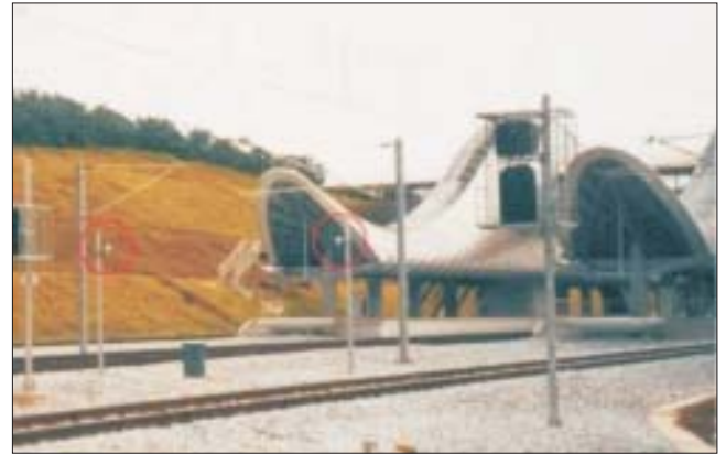
Fig. 6 • Express Rail Link KLIA à Kuala Lumpur Emetteurs – IR à côté du rail
