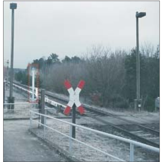
Fig. 3 • S-Bahn Berlin GmbH Ligne S1 émetteur IR sur le côté du rail
