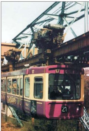
Fig. 1 • Train suspendu de Wuppertal
